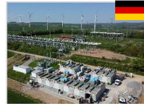
BCP Battery Holding Batterie-Speicherkraftwerk
